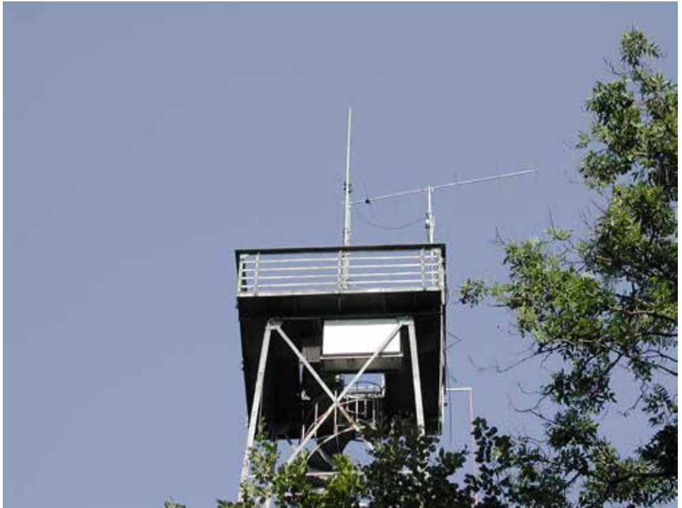
Bild 1 zeigt die 8 Element Yagi auf dem Turm.
